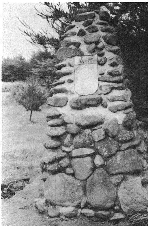
岡山連盟結成25周年記念野営大会で建設した第2ケルン (位置を移動後のもの)
